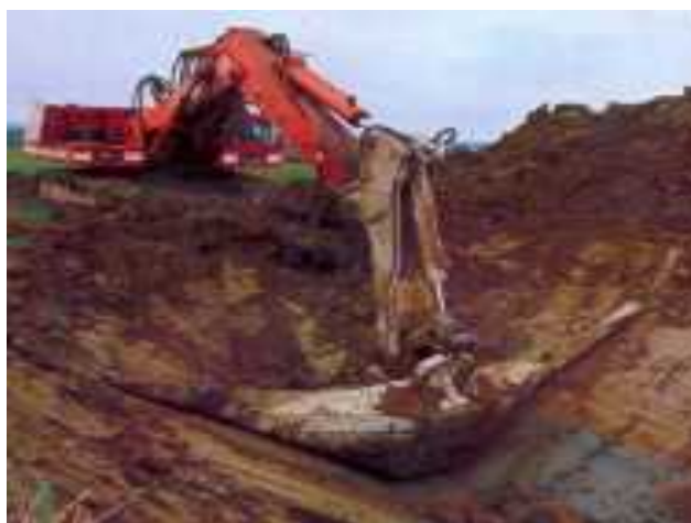
Slika 23. Iskop detaljnih kanala s profilnom trapeznom korpom
